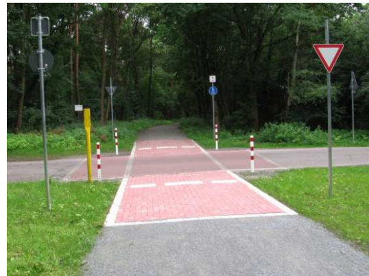
Abb. 12/13: Beispiel für farbliche Markierungen der Poller und den Einsatz von Warnhinweisen
