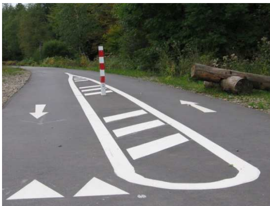
Abb. 1: Beispiel für Poller auf einem Radweg mit auffälliger Farb- und Fahrbahnmarkierung
